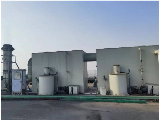
丙二车间楼顶 (DA003)
