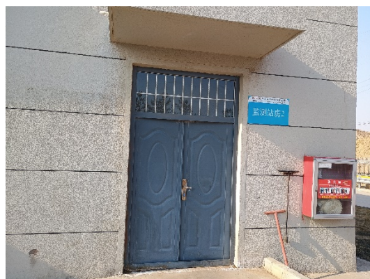
废水自动监测设施
