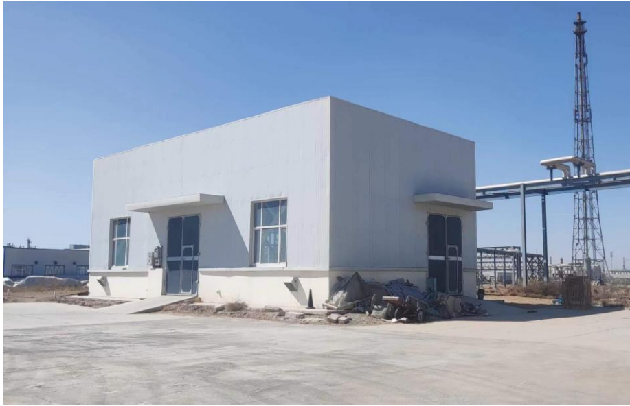
甲类库建设现状
