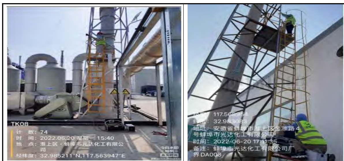
图 6.2-1 同类型项目废气处理措施图
