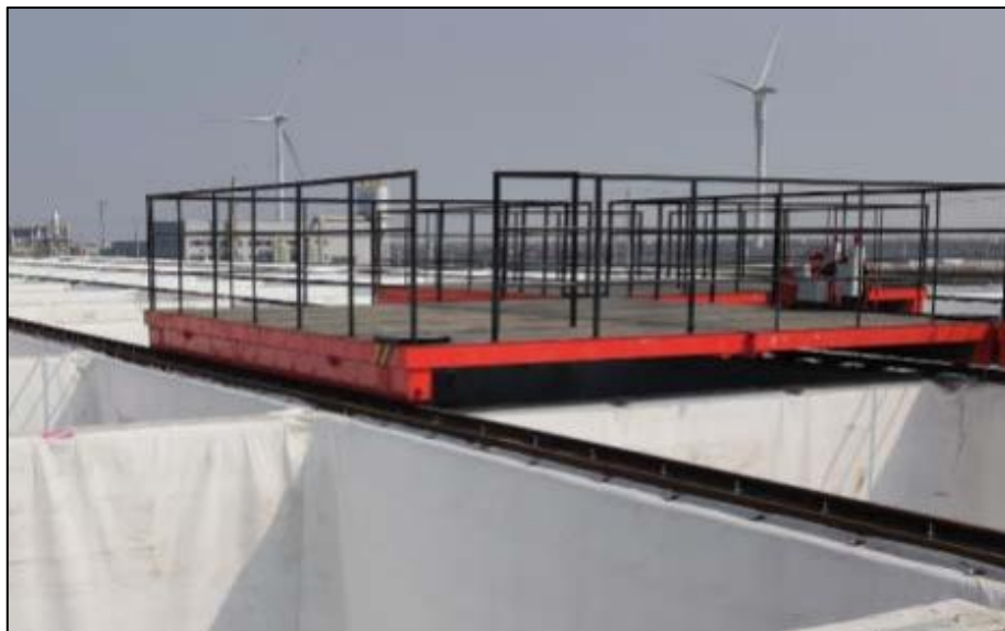
图 3.1-3 移动平台式遮雨棚作业平台示意图
