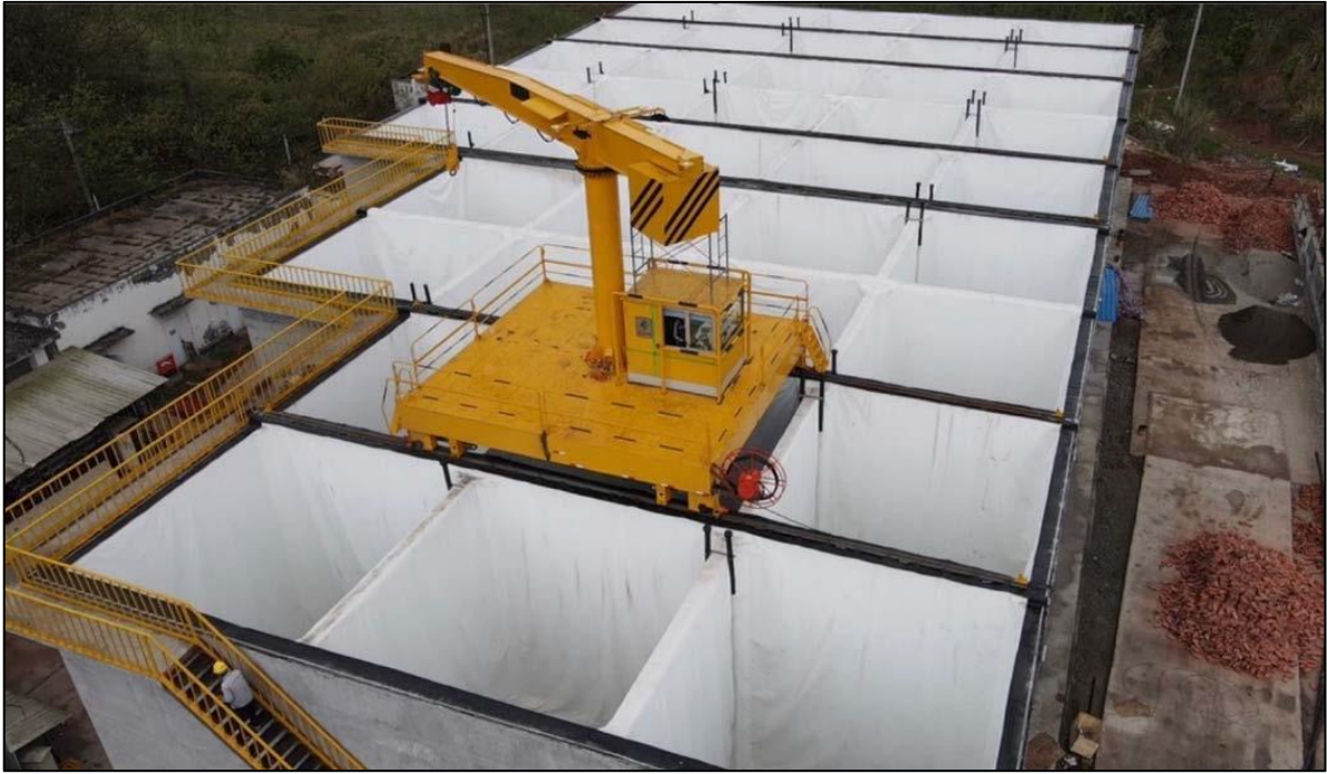
图 3.1-4 悬臂吊装上料系统设备作业图
