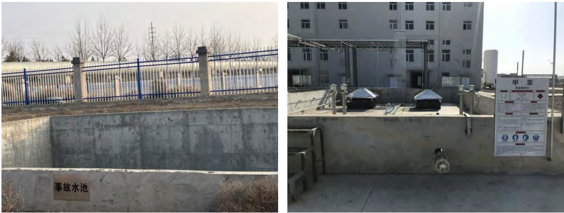
图 2.2.6-1 现有工程事故水池及罐区围堰
