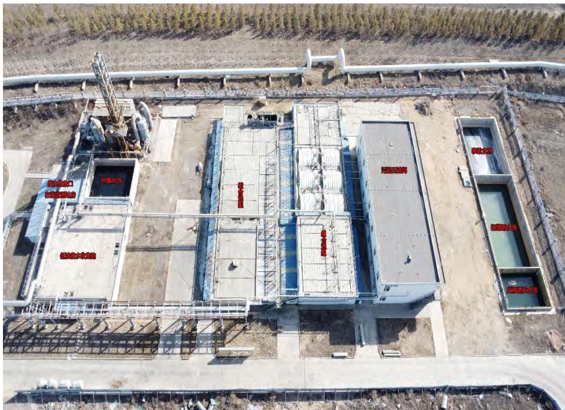
图 2.2.2-1 现有工程污水处理站
