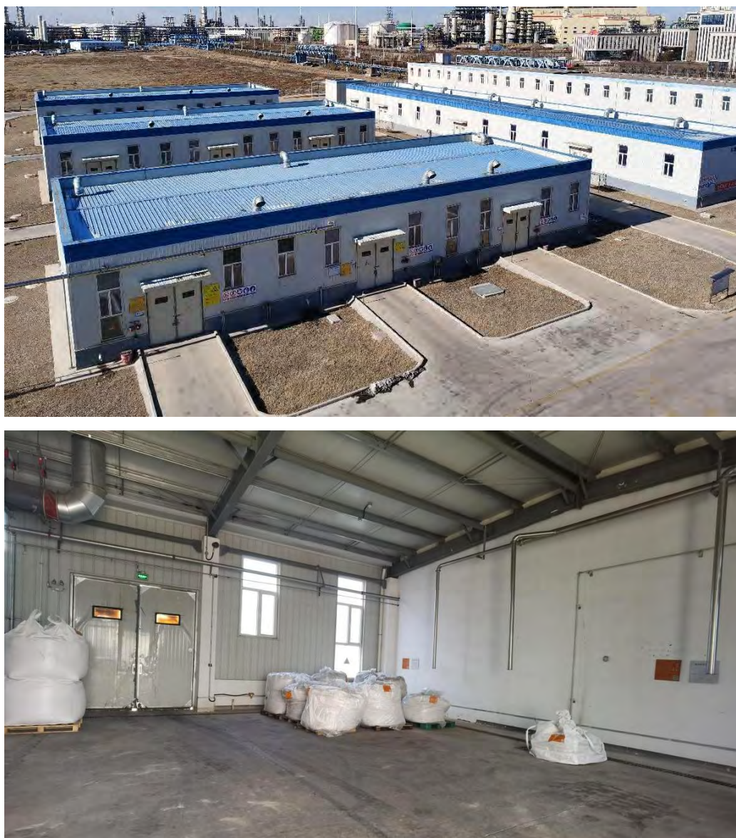
图 2.2.3-1 现有工程危废贮存库(外部、内部)
