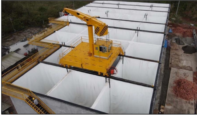
图 4.2-3 悬臂吊装上料系统设备作业图
