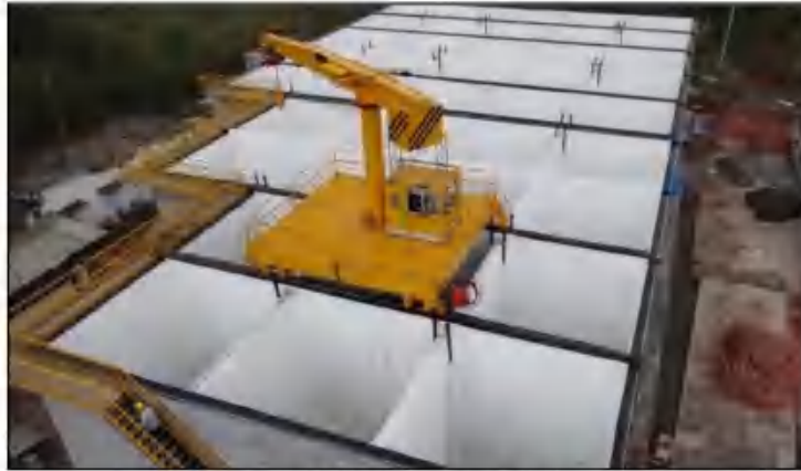
图 4.2-3 悬臂吊装上料系统设备作业图
