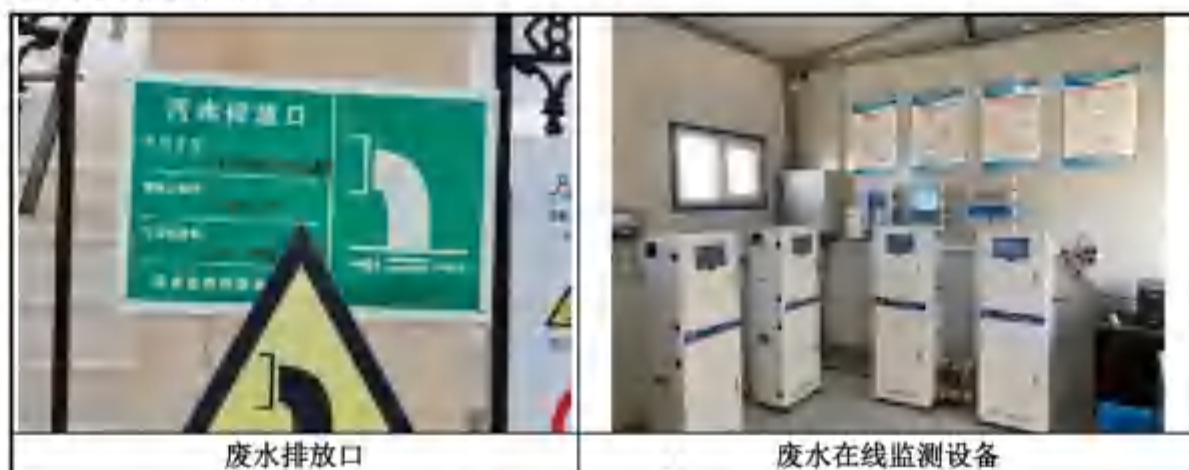
图 2.4.7-2 废水在线监测设施图
