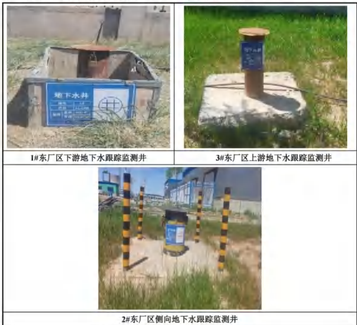
图 2.4.5-1 东厂区地下水跟踪监测井照片
