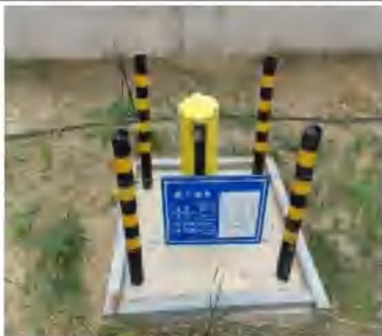
003 西厂区上游地下水跟踪监测井
