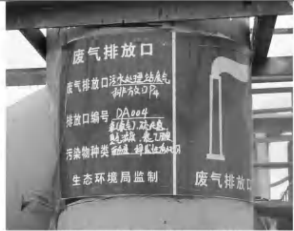
污水处理区废气排放口 (DA004)
