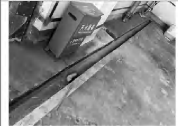
危废贮存库导流槽
