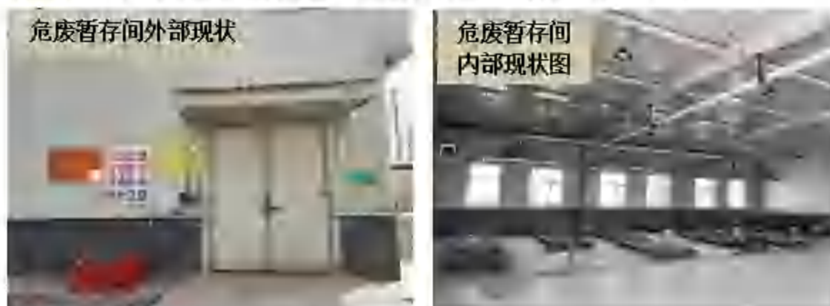
图 2.1.5-3 危险废物贮存库现状图
