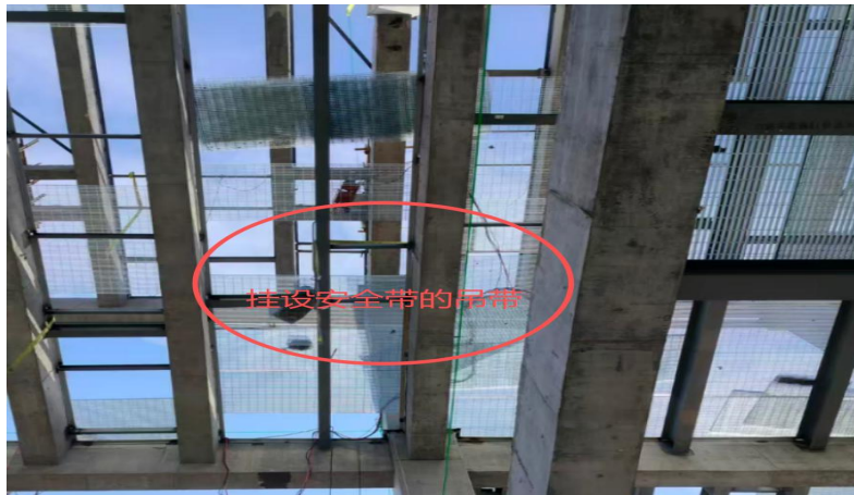
图五 挂设安全带的吊装带示意图
