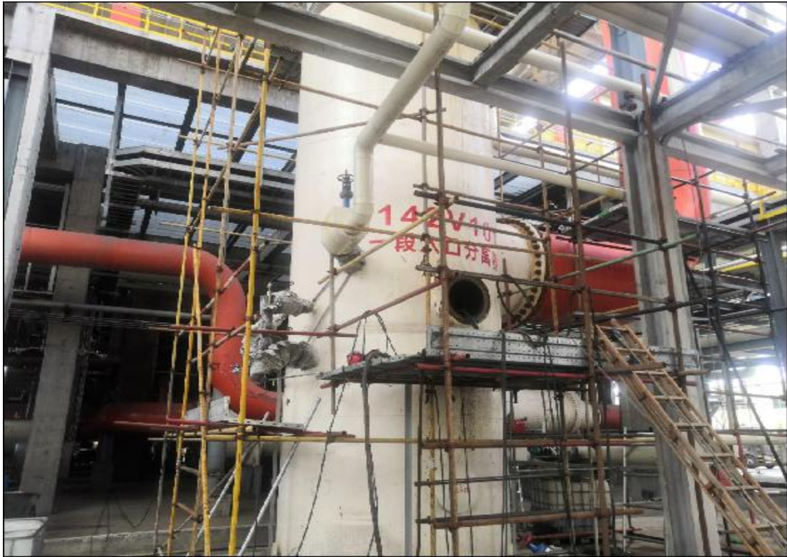
图3 分离器外观及现场脚手架平台
