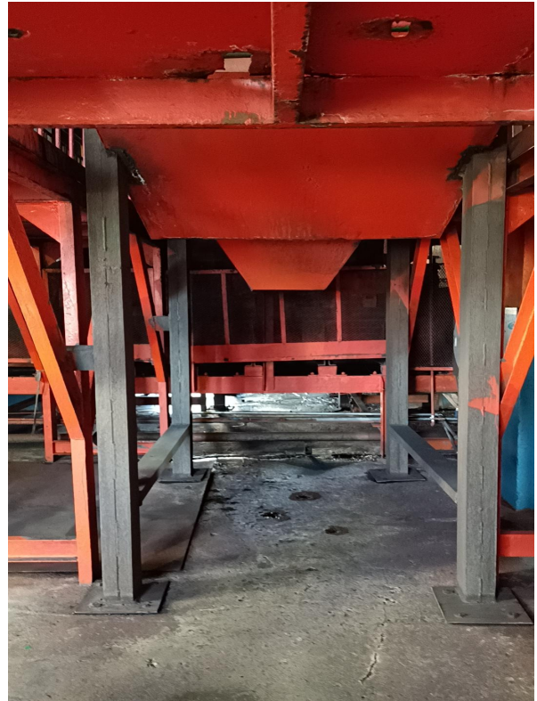
图 2.3-41 梅花井洗煤厂给煤机进行了加固（刷灰色油漆为加固措施）
