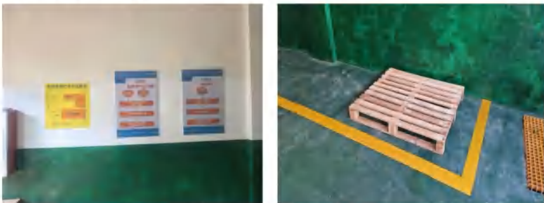
图 4-1 危废暂存间现状
